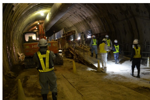
トンネルインバート施工状況の見学
