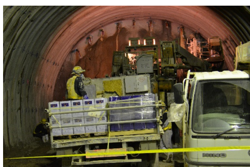
トンネル掘削状況の見学
