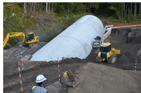
ICT土工・盛土工事状況の見学
