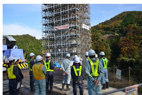
橋脚施工状況の見学
