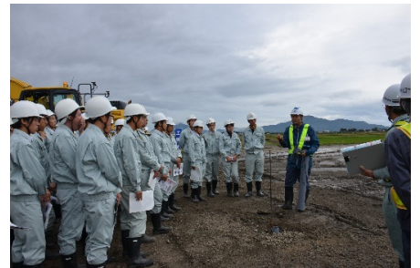
盛土載荷重工法・地表面沈下計
