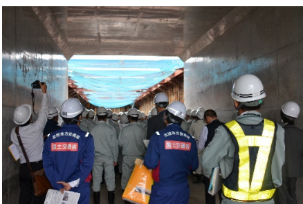
ボックス工事
