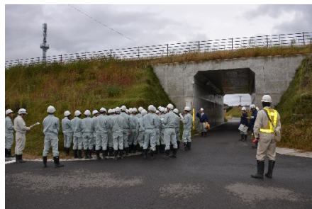
ボックス、補強盛土
