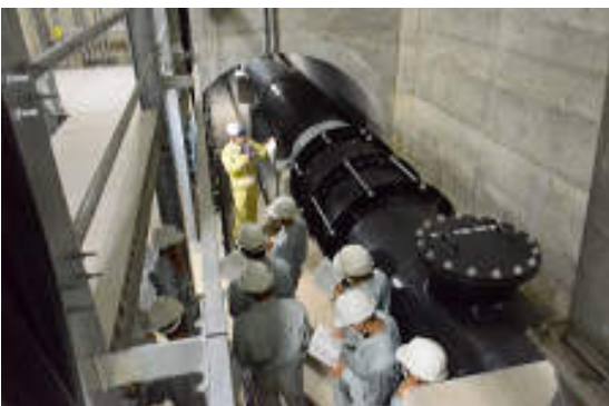
共同横断管の見学(栗ノ木道路工事現場)
