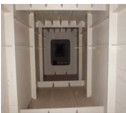
図-3 一般的な箱桁の断面
