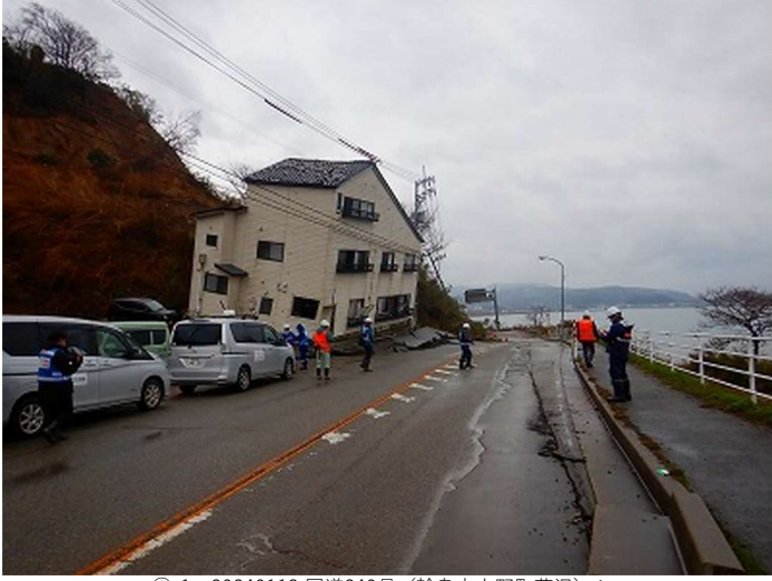
③-1 20240118 国道249号 (輪島市大野町菰沢) .jpg
