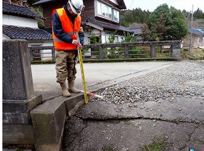
©-2 240209_橋梁緊急点検-2_珠洲市.jpg
