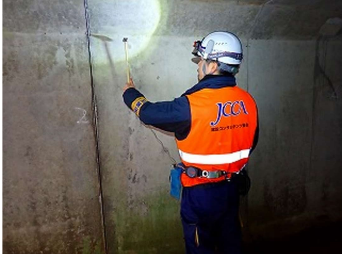
©-1 240209_橋梁緊急点検-1_珠洲市.jpg
