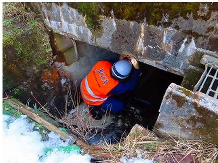
©-6 240209_橋梁緊急点検-6_珠洲市.jpg
