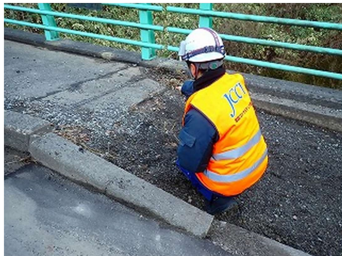
©-4 240209_橋梁緊急点検-4_珠洲市.jpg
