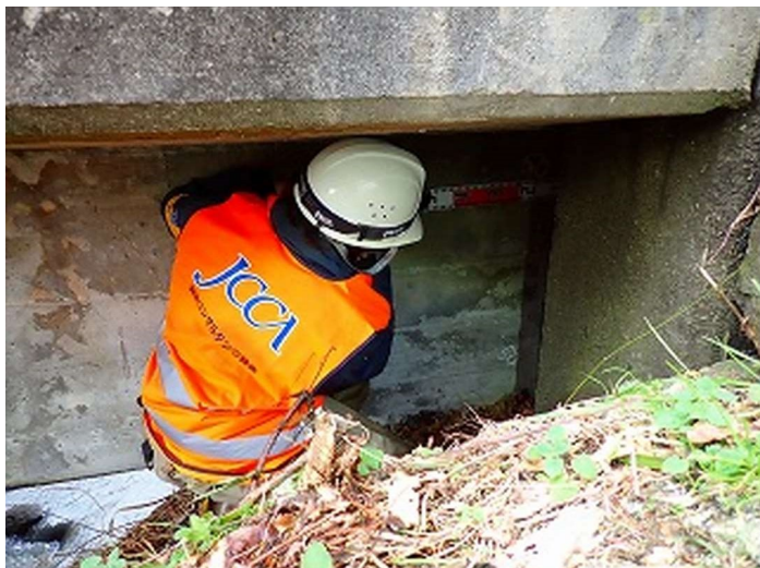
©-3 240209_橋梁緊急点検-3_珠洲市.jpg
