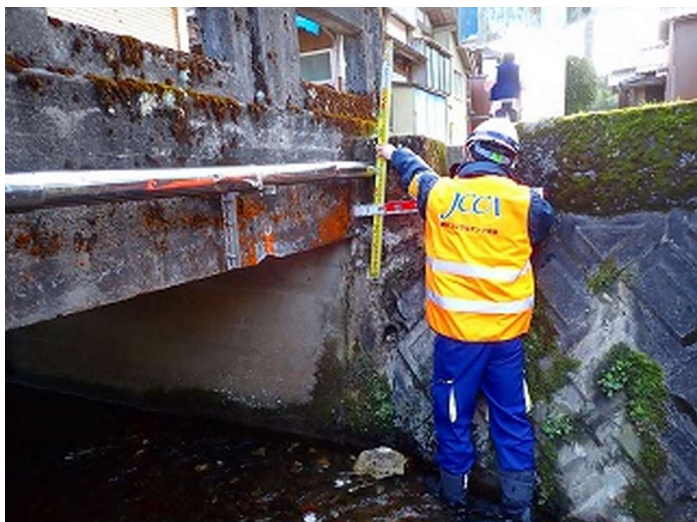
©-5 240209_橋梁緊急点検-5_珠洲市.jpg
