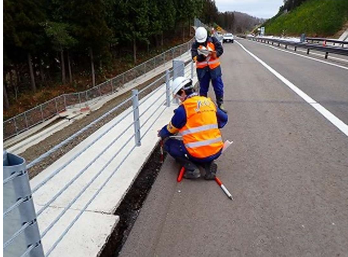
⑦-2 240215_路面被災状況調査_国道470号輪島道路（三井町）.jpg
