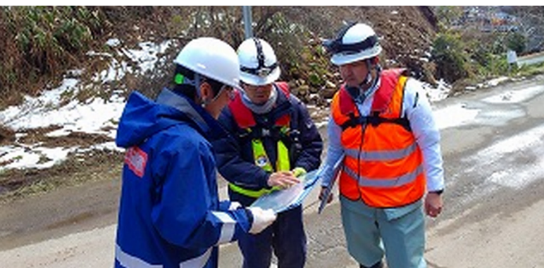
⑧-3 240307_斜面崩壊に伴う河道閉塞調査_河原田川 (輪島市熊野地先) .jpg
