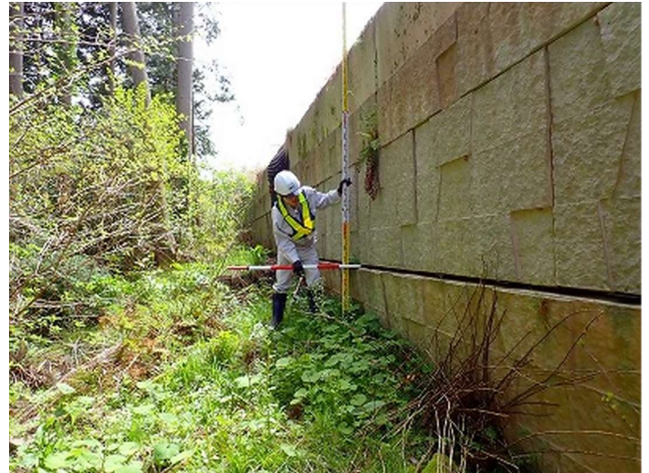
⑪-4 240423_38号和島浦上線_奥能登土木事務所.jpg
