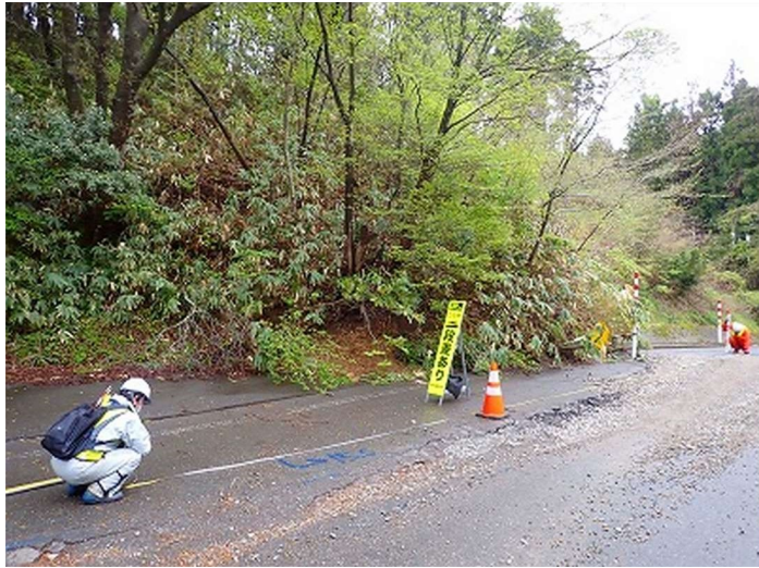
⑪-11 240424_266号五十洲亀部田線_奥能登土木事務所.jpg
